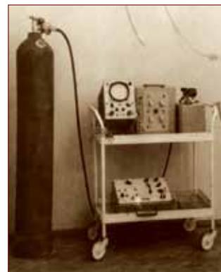
Фото 8. Внешний вид устройства для внутриаортальной контрпульсации
